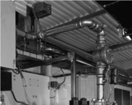
Edelstahlschläuche in Versorgungsleitungen von Gebäuden
